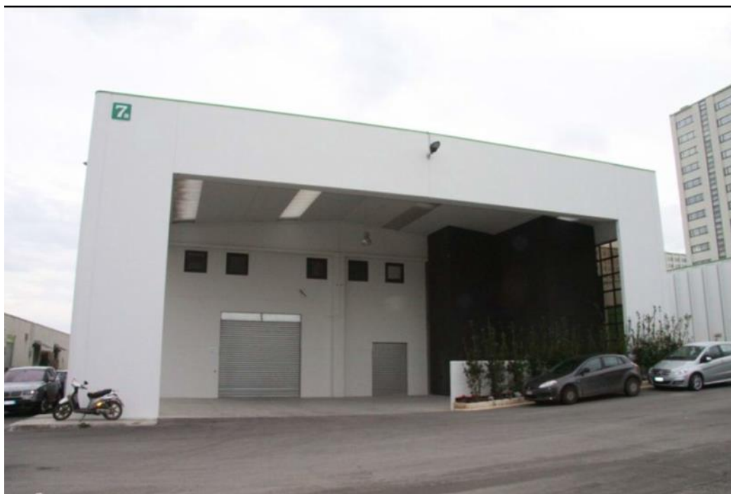
Fig. 7 – Vista ingresso centrale logistica, presso il centro commerciale il “Baricentro”, Comune di Casamassima (BA)
