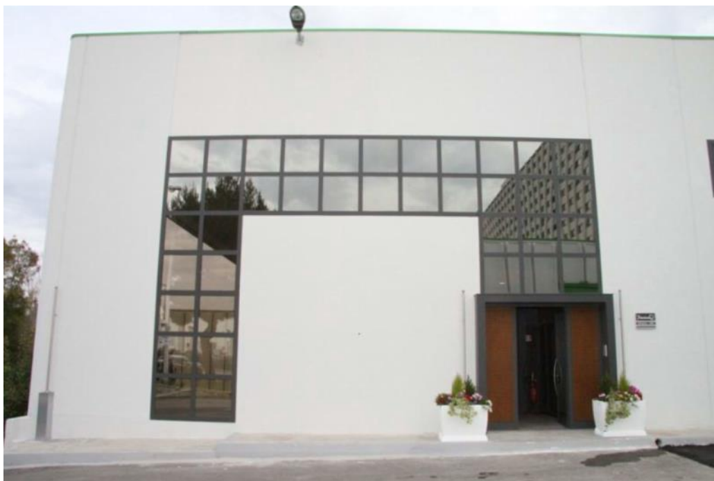
Fig. 8 – Ingresso uffici direzionali ed amministrativi centro commerciale il “Baricentro”, Comune di Casamassima (BA)
